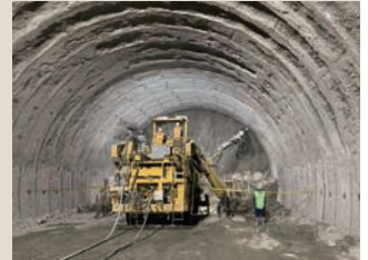
▲中央アルプストーンネル(松川工区)本坑掘削工事
